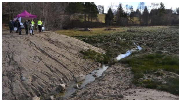
Retenue d'eau artificielles supprimée à Maussac pour restaurer une zone humide. Un projet financé par l'Agence de l'eau.
